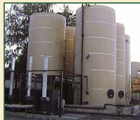
Tanques de almacenamiento en una planta de biodiesel.
