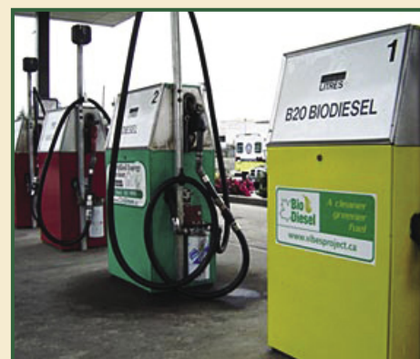
Bombas surtidoras en una estación de biodiesel.
